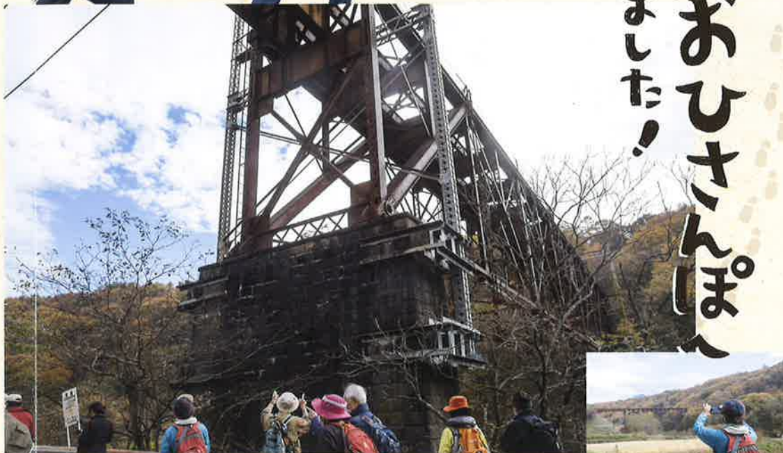
映画『風立ちぬ』にも登場する旧立場川橋梁の迫力に圧倒される。
