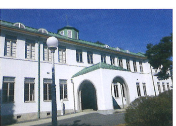
41 旧帝室林野局木曾支局庁舎 (木曾町)D-4 御料林(皇室財産)を管理・経営した庁舎。木曾山の威光と歴史を今に伝える。
