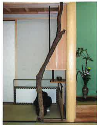
▲南天の中柱 Nanten-no-Nakabasira 書院10畳の間の床脇に中柱として南天を使う。幹周り24cm。
